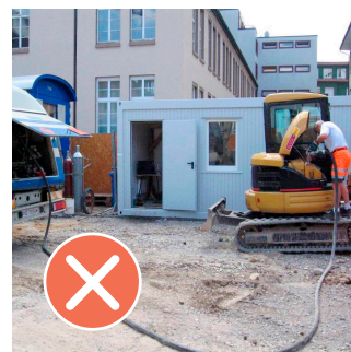
Le tuyau est trop long et sans protection de passage. Opération de ravitaillement pas avec deux personnes
