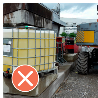
Bac de rétention manquant, distance trop faible par rapport à la machine de chantier
