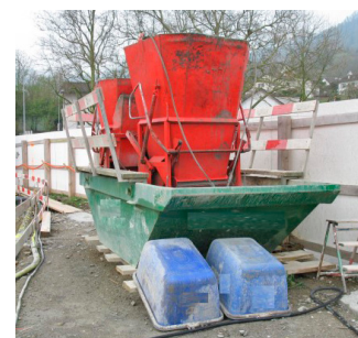
Exemple de lavage de bacs au-dessus de bennes pour la restitution avec un camion-bétonnière
